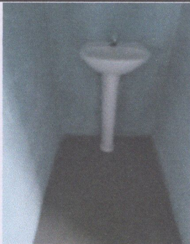
Foto 5: Lavamanos instalado con sus accesorios
