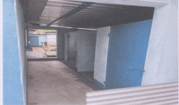
Foto 2: Construccion y techado de baños
