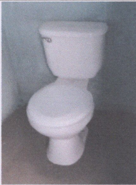
Foto 3: Sanitario instalado con sus accesorios
